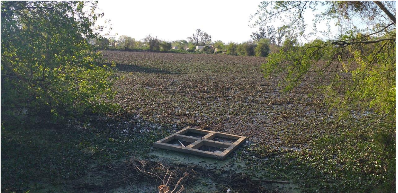
Figura 4 Salida de laguna facultativa existente. (Vista hacia el norte).
